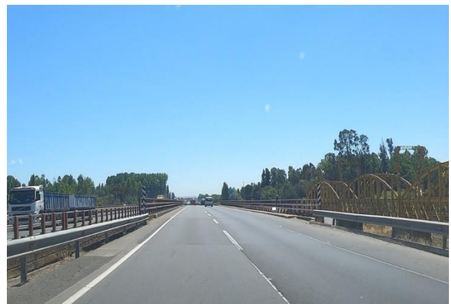
Puente Liguay (Km 315,119)
